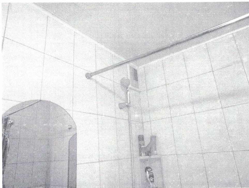
Фото №8. Фрагмент ванной. Четвертый этаж квартира №56. Уменьшено сечение вентиляционного канала.
