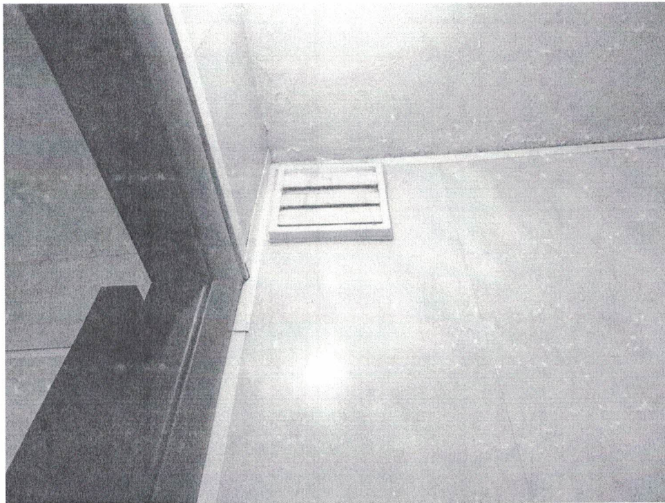
Фото №7. Вентиляционный канал. Пятый этаж квартира №60. Вентиляционный канал перекрыт.
