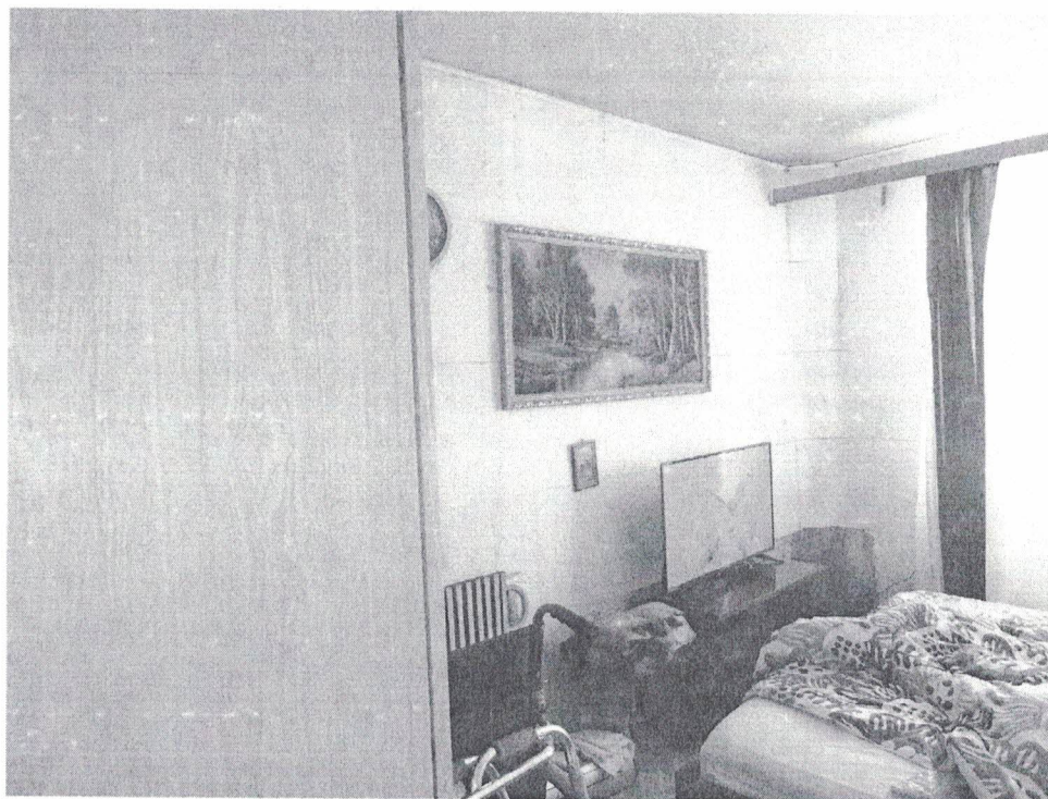
Фото №9. Фрагмент жилой комнаты. Третий этаж квартира №52. Следы увлажнений на перекрытии в углу у окна.
