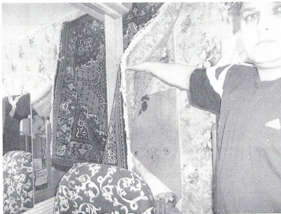
Фото №11. Фрагмент жилой комнаты. Второй этаж квартира №48. На стене следы увлажнений, потемнение внутренней поверхности стены, плесень, грибок.
