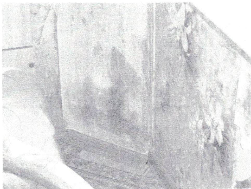
Фото №12. Фрагмент жилой комнаты. Второй этаж квартира №48. На стене следы увлажнений, потемнение внутренней поверхности стены, плесень, грибок.
